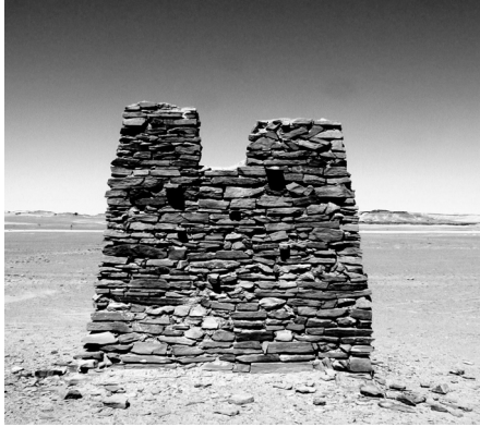
Photo : Architecte Kaci MAHROUR, Timimoun 2001.
