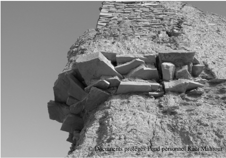
Photo Architecte Kaci MAHROUR, Timimoun, 2002.
